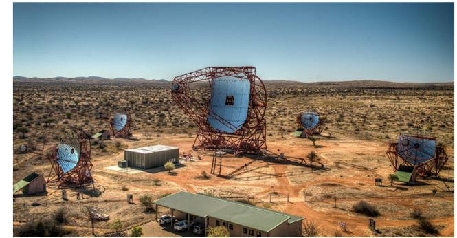
Das High-Energy Stereoscopic System H.E.S.S. Die vier kleineren Teleskope bilden die Ecken eines 120-Meter-Quadrats, in dessen Mitte das fünfte, riesige Teleskop steht.
