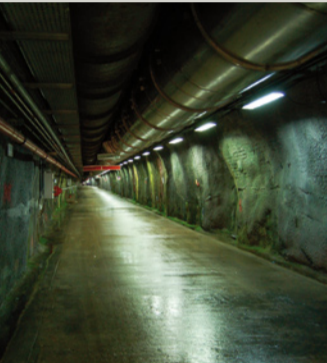
Ein tiefer Tunnel führt in das größte Untergrundlabor der Welt unter den italienischen Abruzzen.
